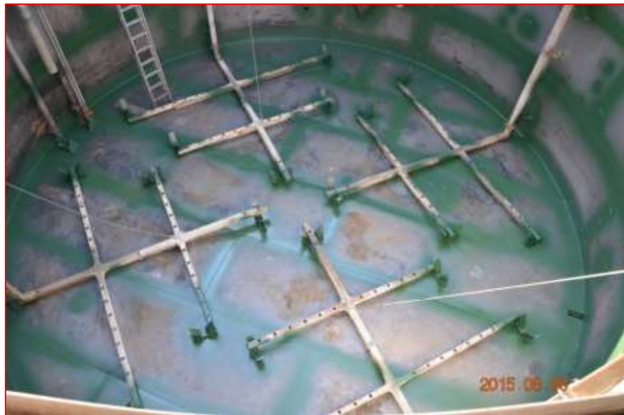
Tankfenék a buborékoltató csövekkel
