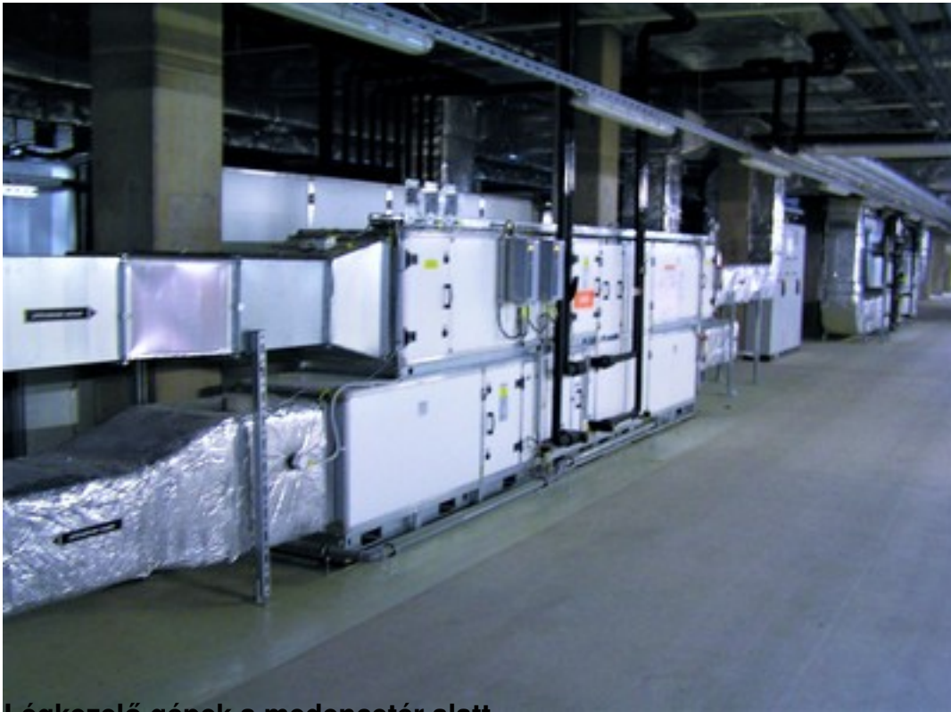
Légtisztító gépek a medencetér alatt
