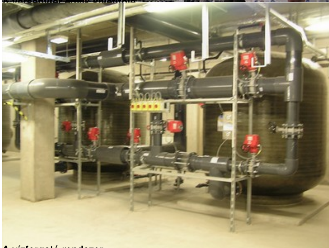
A vízforgató rendszer
