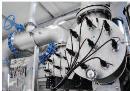
© Wasserwerk Fröndenberg-Menden GmbH
