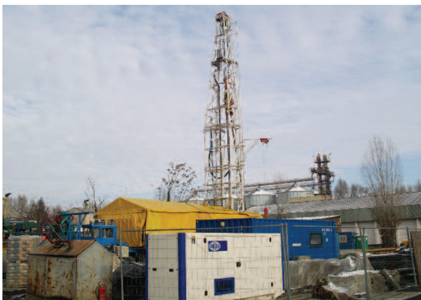
1. kép – Termálkút fúrása Törökszentmiklóson, 2011-ben
