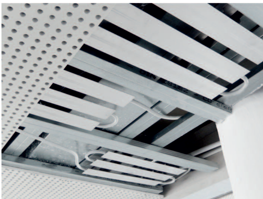
3. kép – Kontakt rendszer alumínium hőátadókkal, kitűnő hűtési/fűtési teljesítménnyel, akusztikai álmennyezethez optimalizálva
