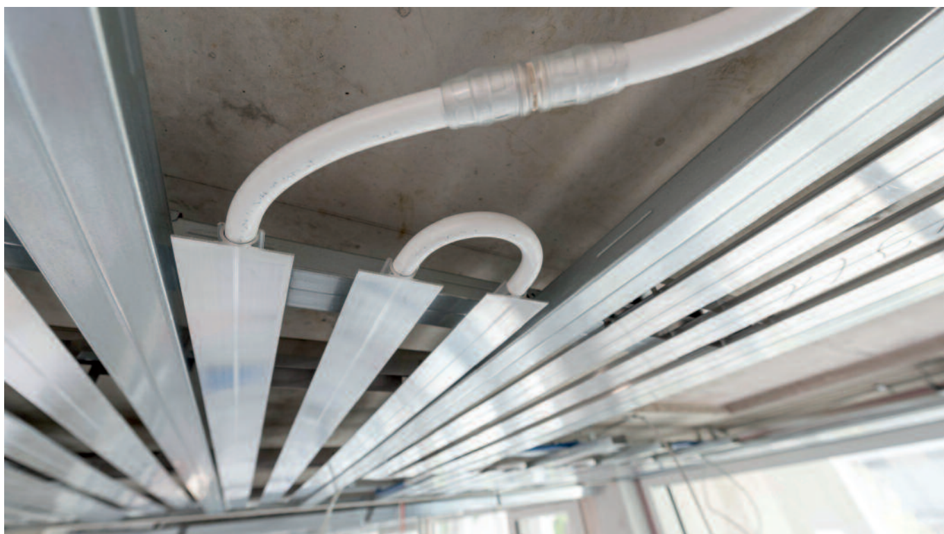
1.kép – Alumínium hőátadókkal a magas teljesítményleadásért, köztük résekkel a kitűnő hangelnyelésért
