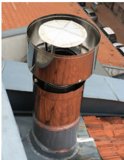
2. kép: Fémanyagú LAS-kémény tetőn kívüli szakasza
