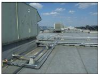
Rooftopok beépített glikol-levegő hőcserélővel
