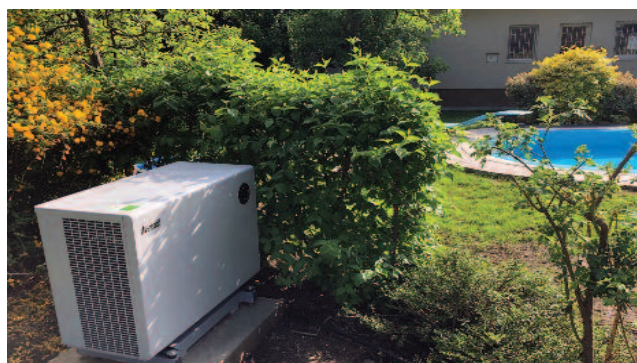
7. ábra – Medence mellé telepített hőszivattyú, diszkréten megbújva a növényzet mögött
