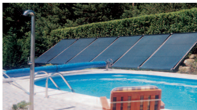
4. ábra – Medence fűtése lefedés nélküli napkollektorral
