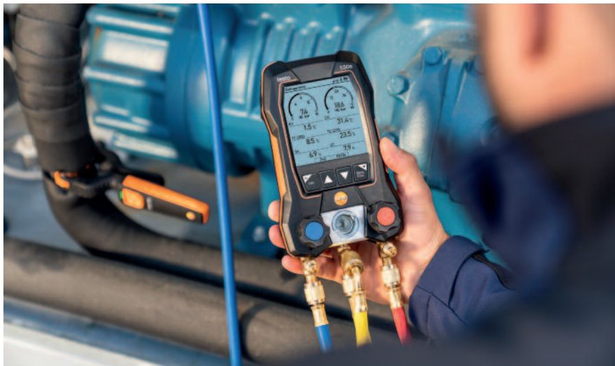
Mérés testo 550s műszer használatával
