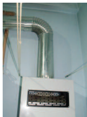
A készülék égéstermékét elvezető csöveire, idomaira az 1969. évi VII. törvényt meghívató, akkor kötelező MSZ 7044 szabvány előírásai vonatkoznak
