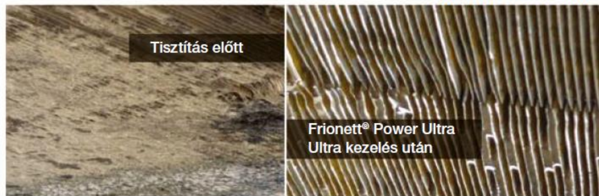
Kondenzátor tisztítása
