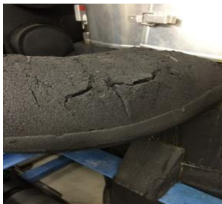
Kondenzáció és korrózió
