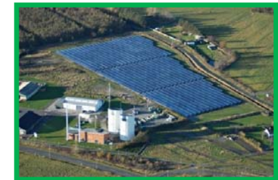
Solar District Heating Napkollektoros távfűtés
