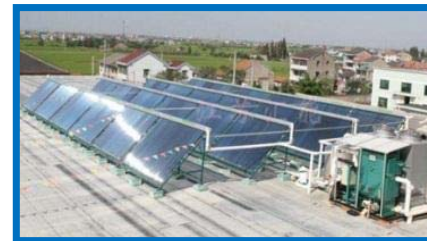
Solar Cooling Napkollektoros hűtés
