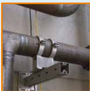
Fali rögzítés MPT konzollal
