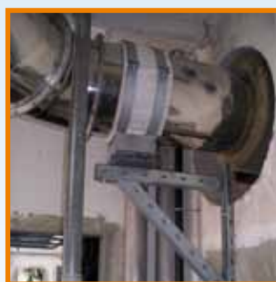
Alátámasztás MPT tartóprofilokkal és konzollal
