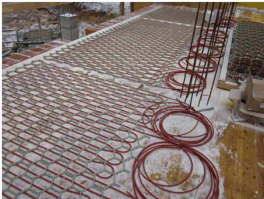
Wavin Tempower új CW-90 aktív beton födémbe épített rendszer
