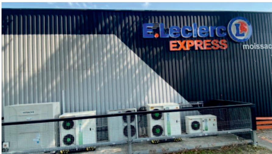
Három Pecomark R-455A aggregát telepítése
