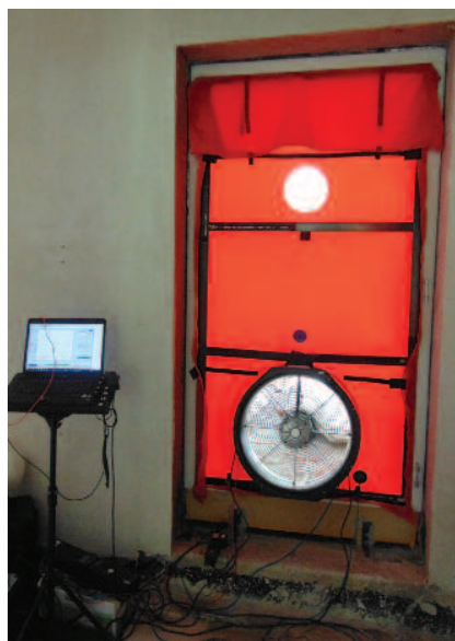
1. kép – Blower-door mérés a gyakorlatban
