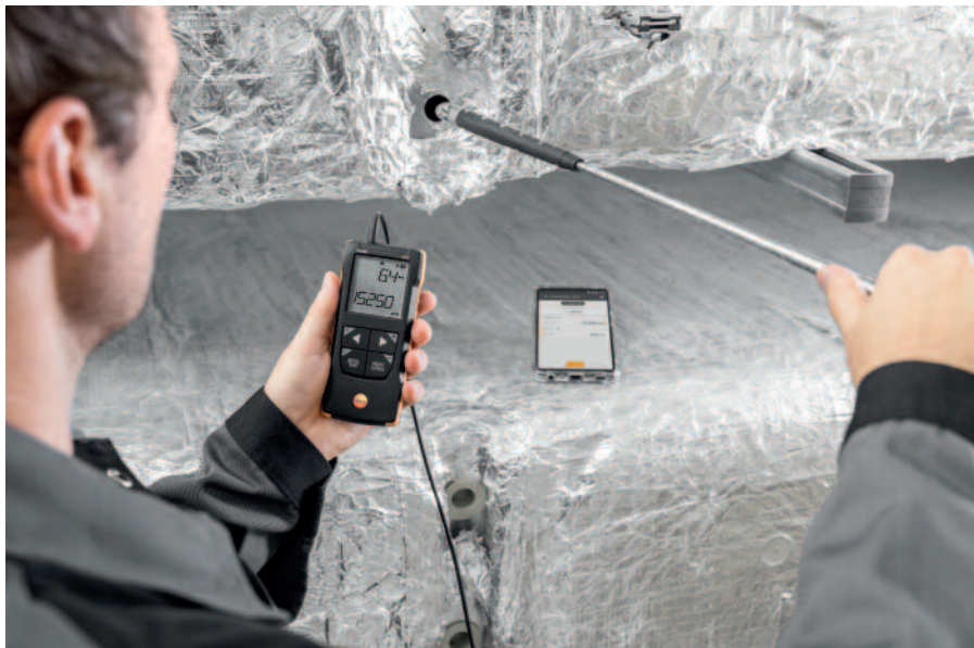
testo 416 levegőáramlás-mérés a szellőztető csatornában
