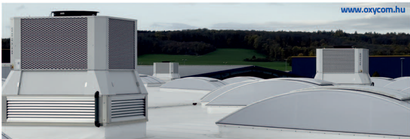
4. kép – IntrCooll Plus kétkörös adiabatikus hűtő- és szellőzőberendezések az NV (Natural-Ventilation) természetes gravitációs szellőzőmodulon
