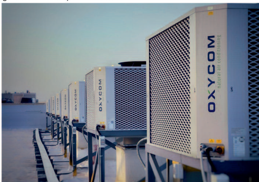
2. kép – IntrCooll Plus kétkörös adiabatus hűtő- és szellőző berendezések
