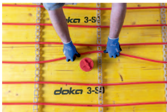
5. kép – Könnyű kikerülés, a cső a rögzítő / távtartó sínből felfelé kihúzható, pozíciója módosítható
