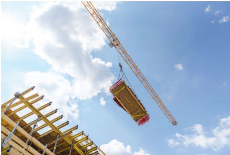
3. kép – Méretre gyártott hűtési/fűtési modulok az építkezésre szállítva
