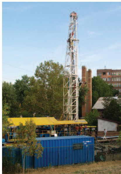
1. kép – A visszاسajtoló kút fűrésa 2012. szeptember 11-én, háttérben a kórház épülete
