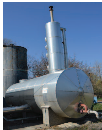
2. kép – A gáztalanító és a puffertartály, háttérben a lehűlt víz 30 m³-es tároló tartálya
