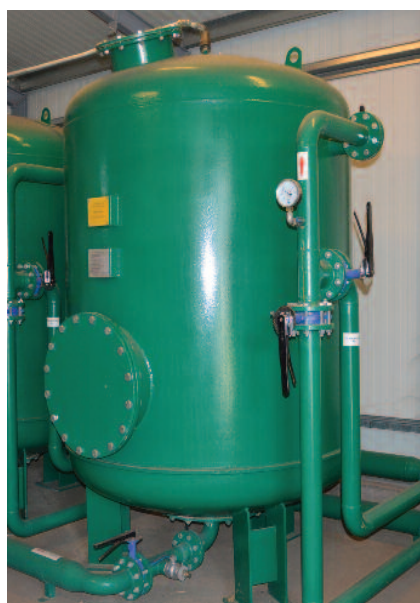
3. kép – A termálvizet szivattyúk nyomják át a kavicsszűrőkön
